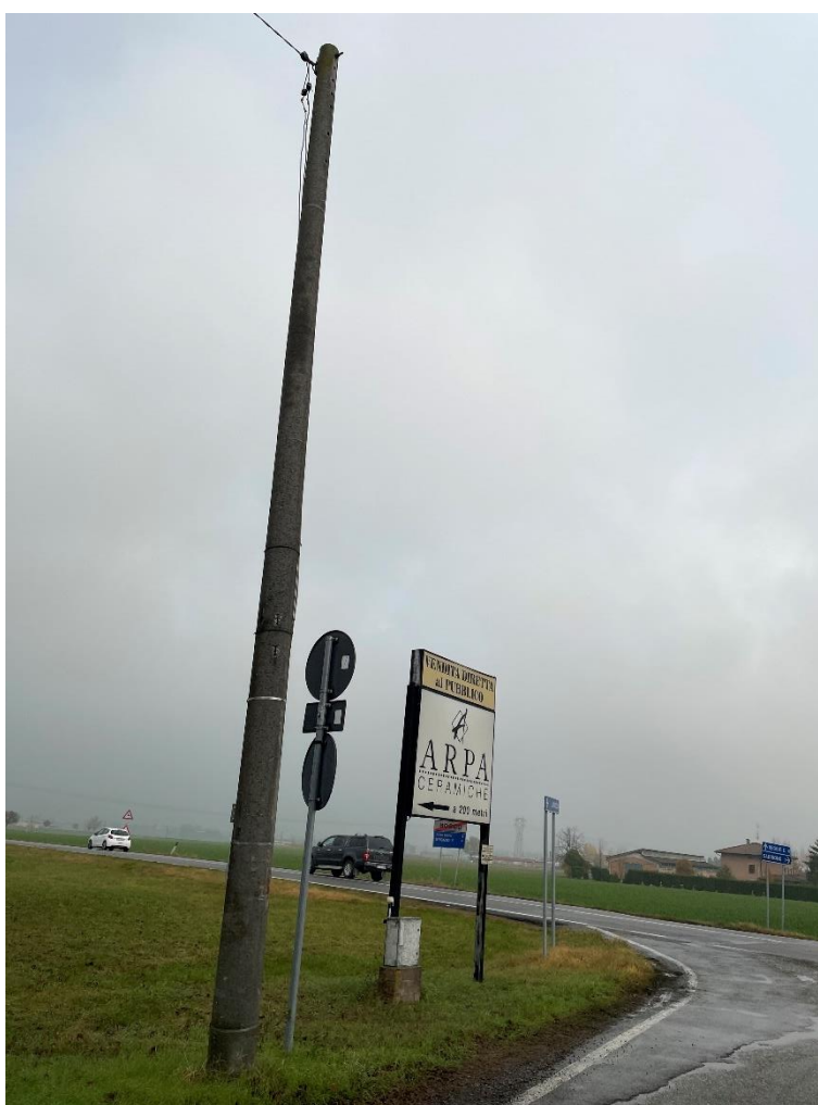
palo linea BT e contatore da spostare
