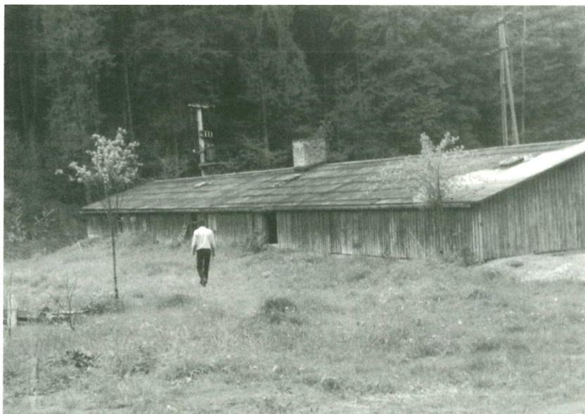
Al Lager 6 di Kabla, oggi
