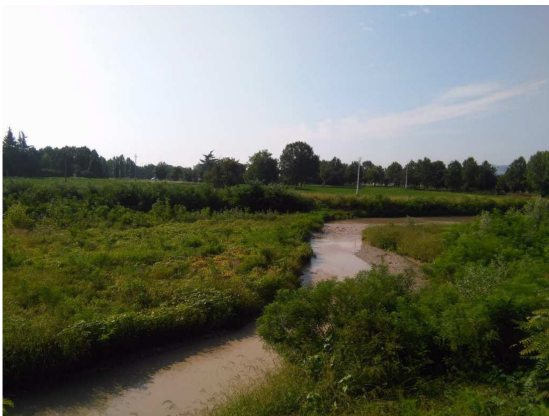
Foto 2 – Tratto del T. Tresinaro a monte dell'attraversamento stradale di Arceto.
