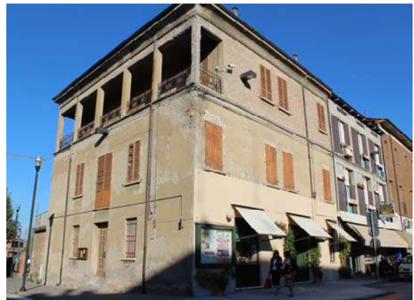
Foto del fabbricato
