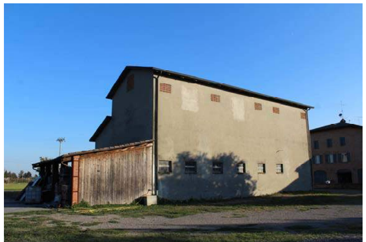
Foto del fabbricato
