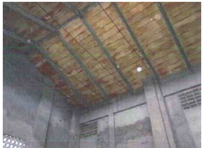
Particolare della copertura
