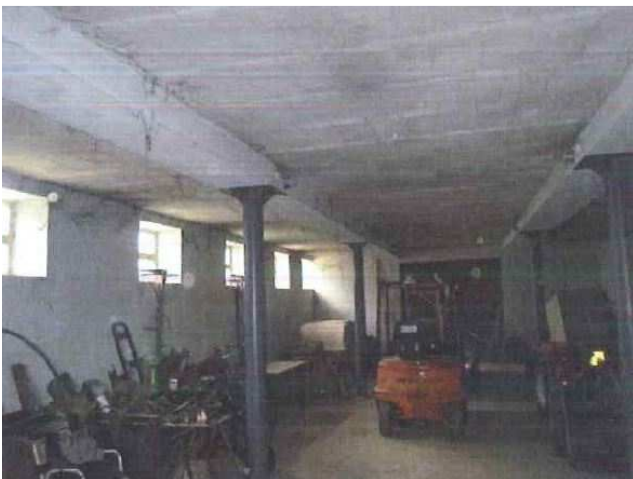
Ex stalla al piano terra
