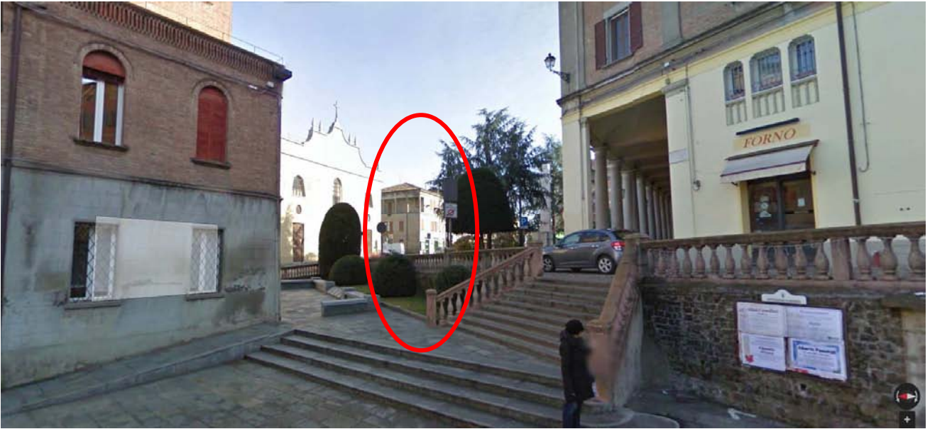
Vista da Piazza della Libertà (Fonte Google Street View)
