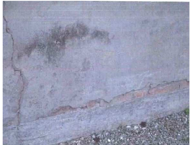
Nuove fondazione realizzate in c.a. e laterizio
