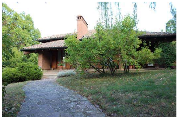
Foto dell' area
