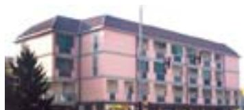
Risanamento delle strutture in cemento armato
