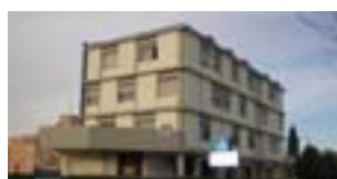
Risanamento delle strutture in cemento armato
