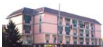
Risanamento delle strutture in cemento armato
